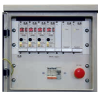
EPB 24 Slave als Mastverteiler für max. 4 Leistungskarten
