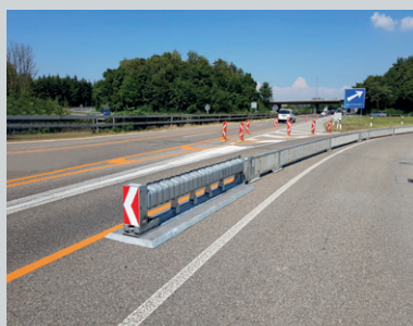
Mobile Anpralldämpfer für ProTec Schutzwände
