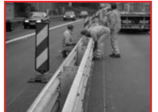
Die "16-m-Stöße" werden mit lediglich zwei Schrauben verbunden
