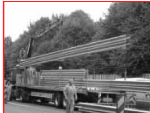
Die Elemente werden abgeladen und an ihrer endgültigen Position abgestellt
