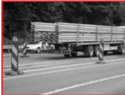
Die vormontierten 16-m-Elemente STGW Quadro T 3 treffen auf der Baustelle ein
