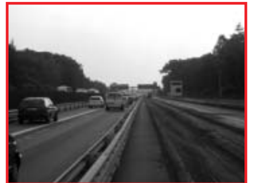
Und schon ist die Wand fertig montiert - die Behinderung im Verkehr war für den Verkehrsteilnehmer kaum zu spüren
