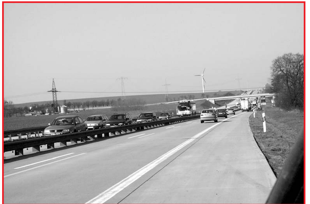
STGW Duo 4: die Prüfkriterien nach den Aufhaltestufen T 1 und T 2 werden erfüllt, tägliche Montageleistung bis zu drei Kilometer
