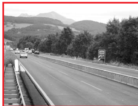
Gegenverkehrstrennung mit der STGW 4200 auf österreichischen Autobahnen
