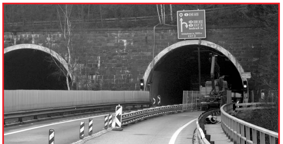
Bei der umfangreichen Baustelle im Berg-Isel-Tunnel wurden alle Vorgaben erfüllt
