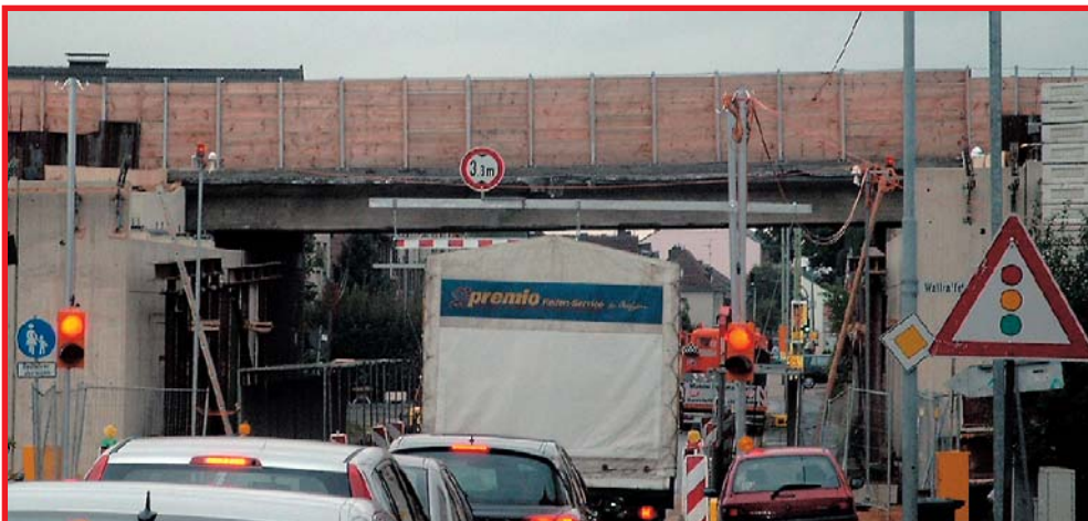
Einsatz unserer Höhenwarnanlage vor einem Brückenbauwerk in Köln
