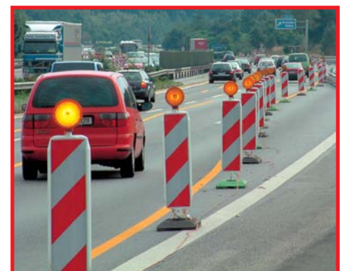
Aufbaulichtanlage mit LED-Technik
