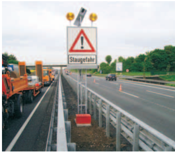
Einrichtung einer Baustelle mit der vollautomatischen mobilen Stauwarnanlage von MIS
