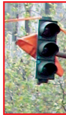
Die bisherigen Abdeckhüllen für Signalanlagen verrutschen allzu oft
